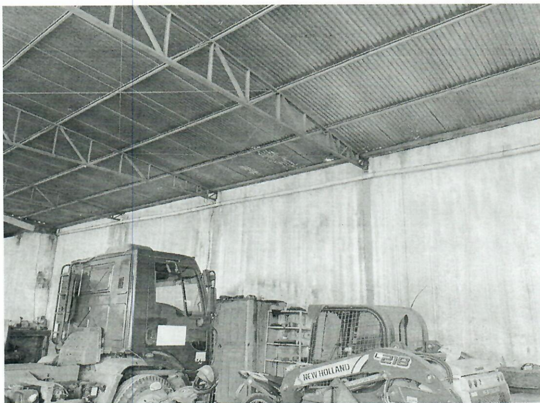
Imagem da estrutura da cobertura do barracão
